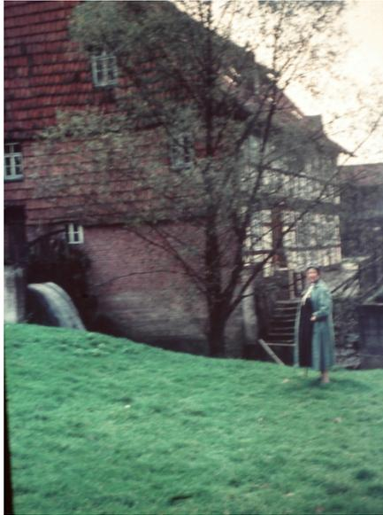
*Abbildung 70: Die Untermühle der Familie Just. Links im Bild fällt das Wasser ungenutzt über das Turbinengehäuse in den Untergraben. Bei der Nutzung verschwindet es im Betonblock und tritt nach Antrieb der Turbine am unteren Ende wieder aus. Die Leistung war wegen des unterschiedlichen Gefälles etwas niedriger als bei der Obermühle. An der Traufseite des Mühlengebäudes erkennt man eine Rampe (Verladeplatz) für das angelieferte Getreide und die Auslieferung des Mehls. Foto 1955*
