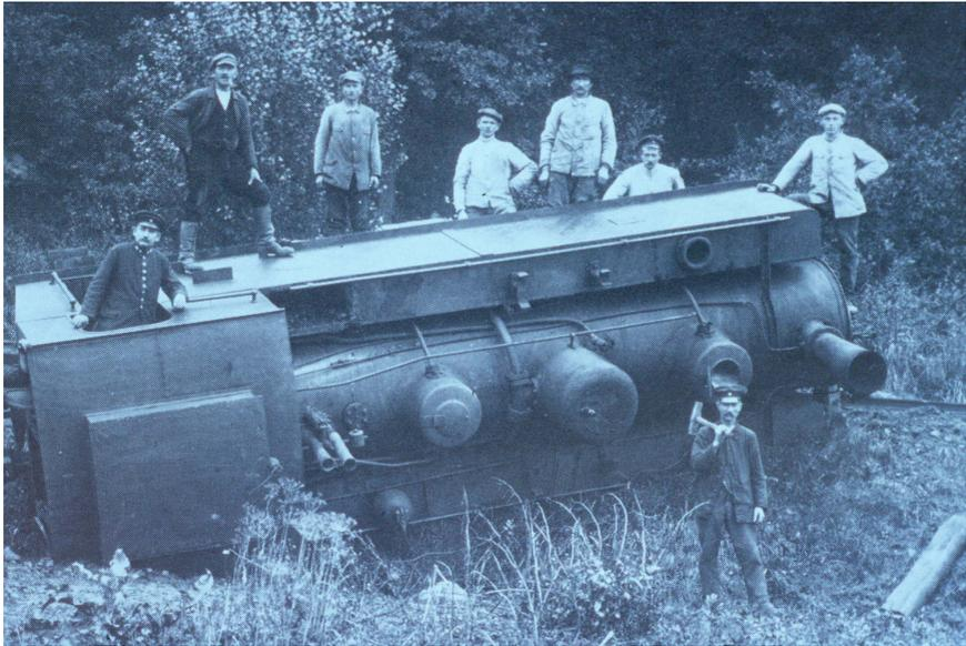
Abbildung 48: *Die entgleiste Lokomotive auf der Strecke etwa 1000 m nach dem Ortsausgang Nesselröden Richtung Duderstadt. Foto 1923*
