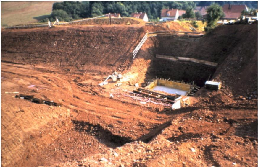
*Abbildung 55: Baggerarbeiten im Bereich „Mistweg“ für die Neubaustrecke Wöllmarshausen/Nesselröden; Das Betonfundament in der Mitte des Fotos zeigt den Baubeginn der Brücke an, welche für den Hohlweg nach Sattenhausen notwendig wurde. Foto ca. 1985*
